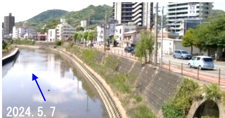
改修後の浦上川 (1997年完了)
