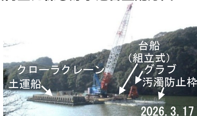
浦上ダム貯水池掘削工事：実施中
