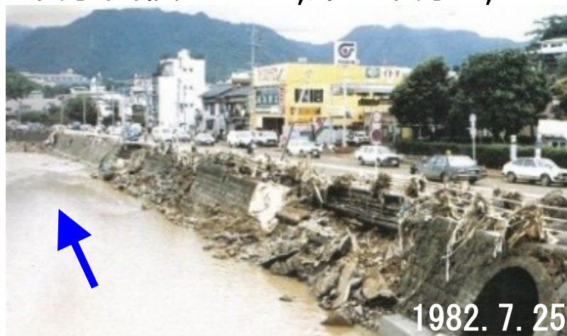
被災した浦上川（下大橋下流部）
