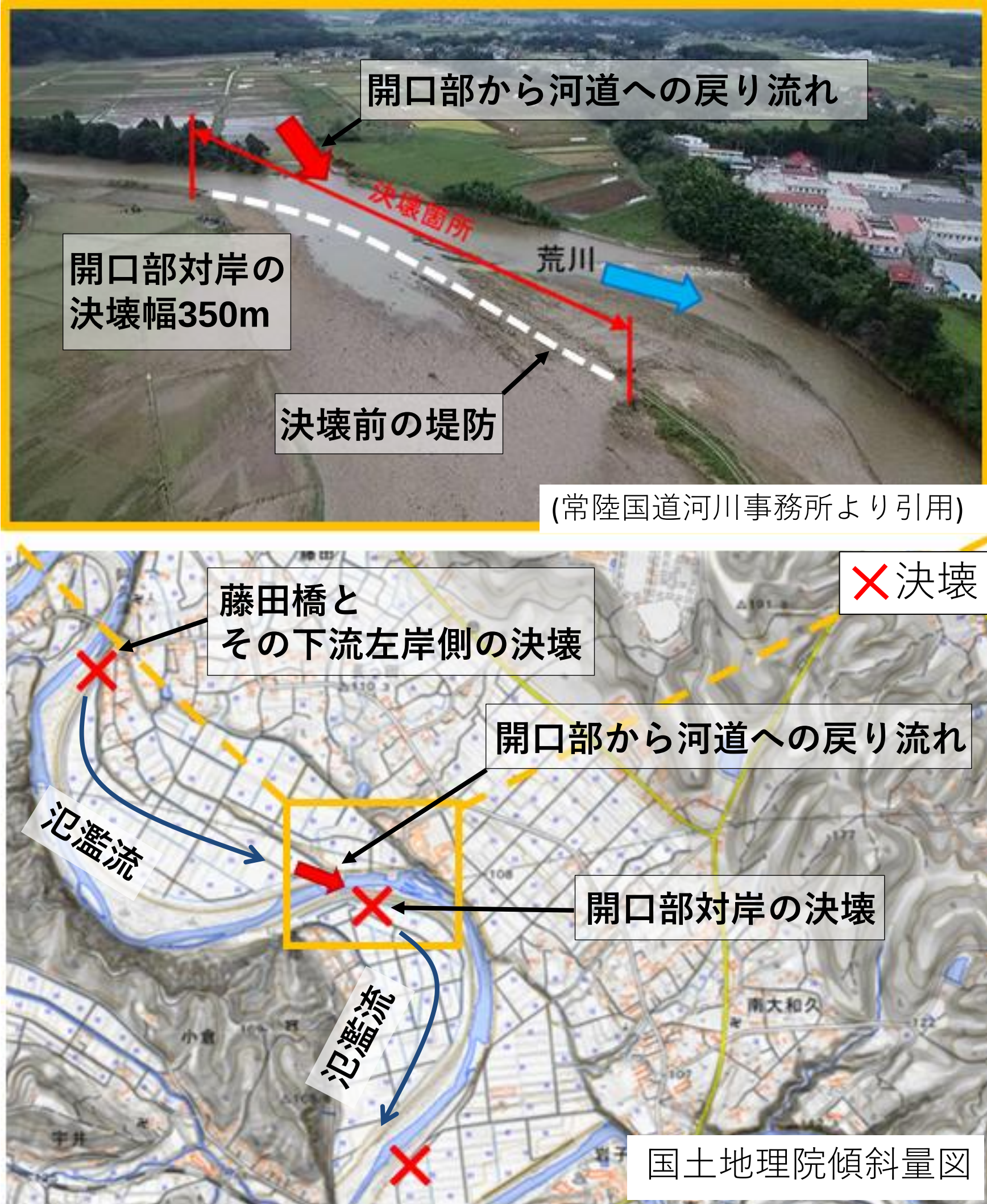
図-1 那珂川水系荒川の藤田橋付近における決壊の様子
