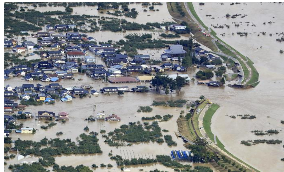
台風19号で長野県千曲川決壊した時の様子 出展：防災ニッポン， https://www.bosai.yomiuri.co.jp/feature/3677 (最終閲覧日：2024.12.3)
