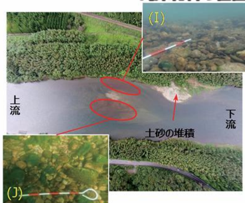
糸状藻類の異常繁茂
