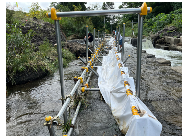
減水後の状況
