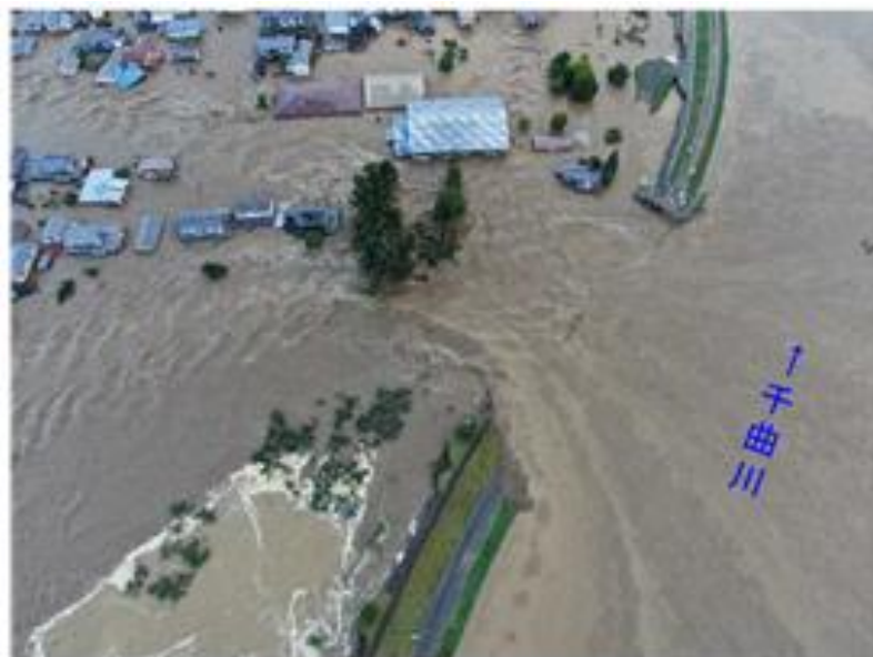
千曲川 堤防決壊地点の様子 1) (57.4km)
