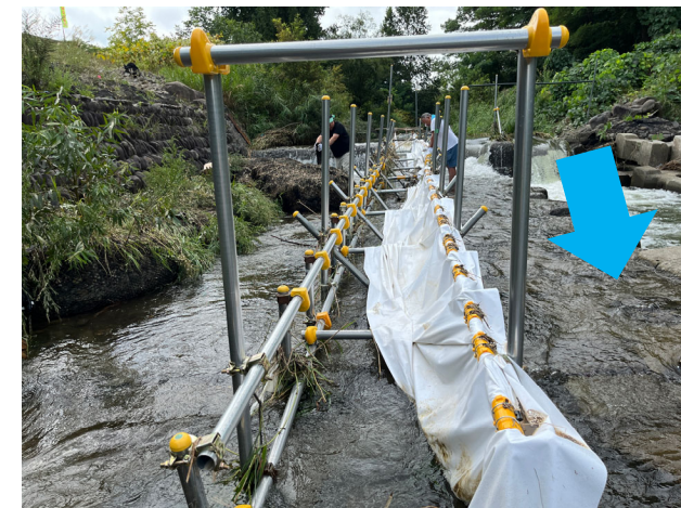
減水後の状況
