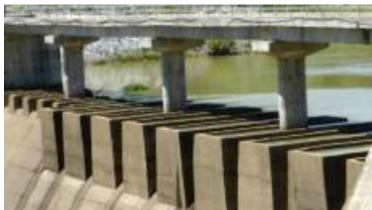
Dak Mi 4B Dam（ベトナム） 3)
