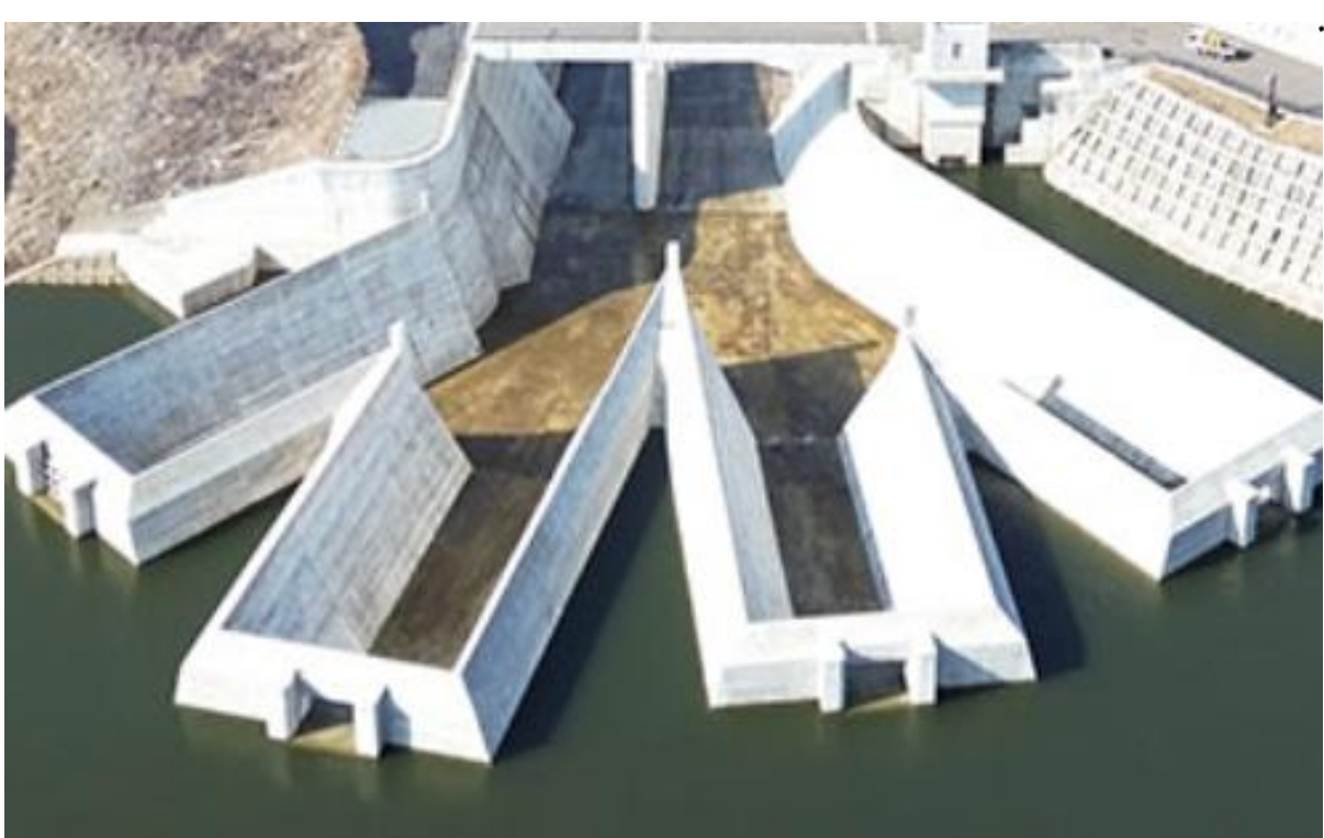
千五沢ダム（フィルダム） 2)
