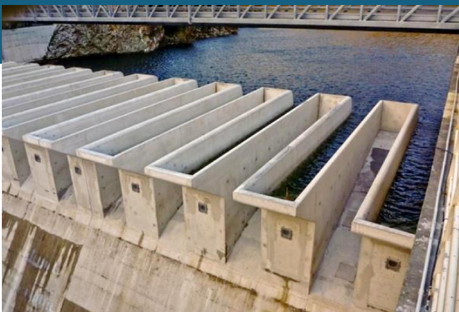
Malarce Dam（フランス） 3)
