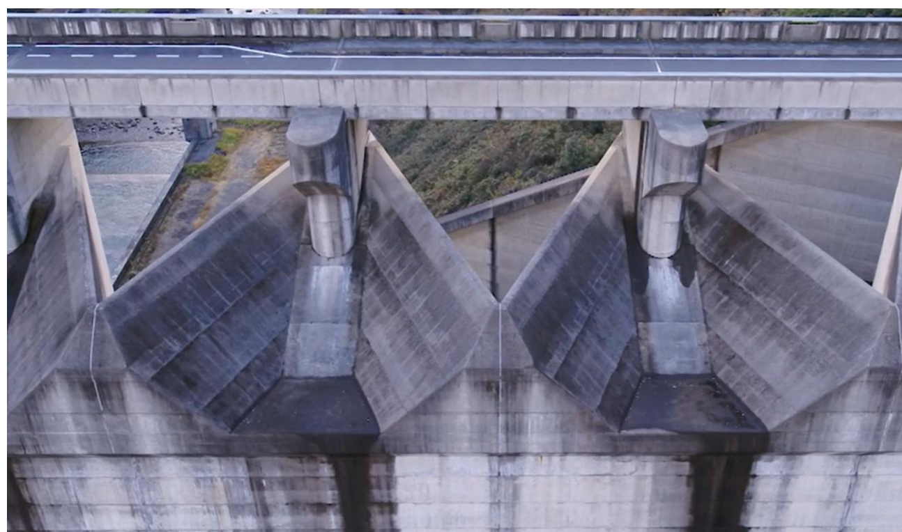
苦田ダム（重力式ダム） 1)
