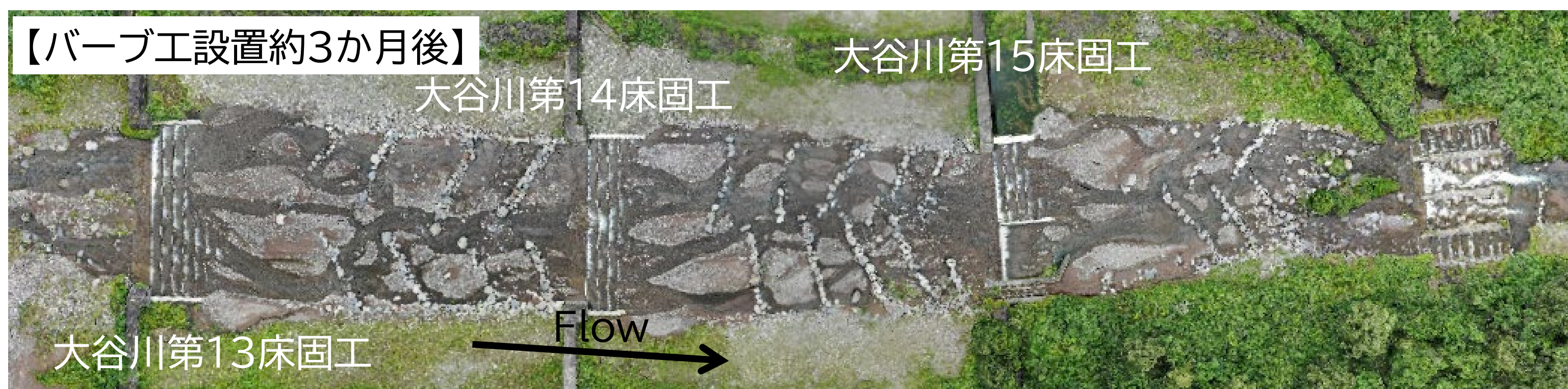
図9 ドローンにより撮影したバース工の写真 (上は2025年6月6日撮影、下は2025年8月13日撮影)
