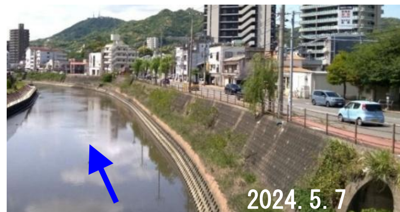
改修後の浦上川（下大橋下流部）
