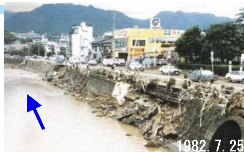
被災した浦上川（下大橋下流部）
