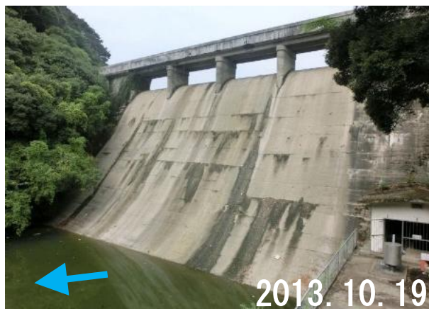
浦上ダムの堤体
