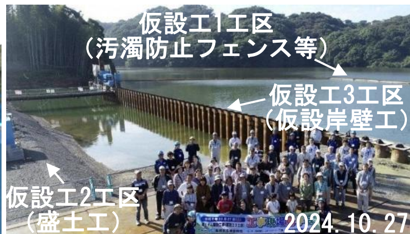
仮設ヤードの整備状況 (現場見学会)
