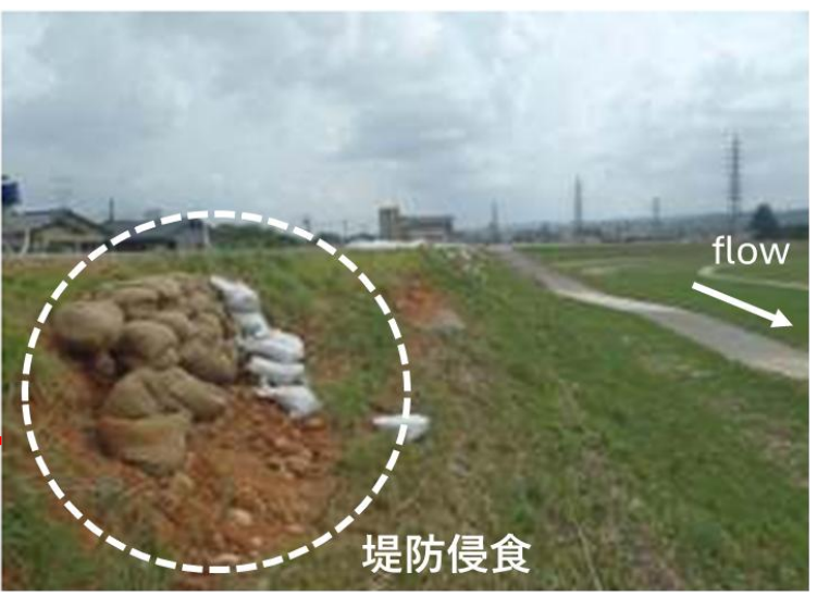
H23年洪水時 堤防侵食 (3.4km右岸)
