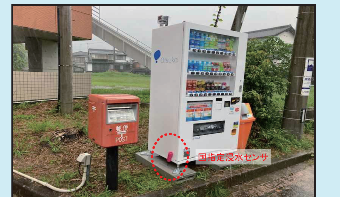
国指定浸水センサ設置例 (高知県いの町)
