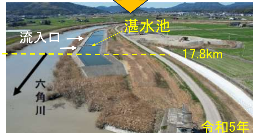
六角川高水敷における湛水池整備
