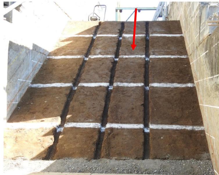
ガリ（溝）設置後直後
