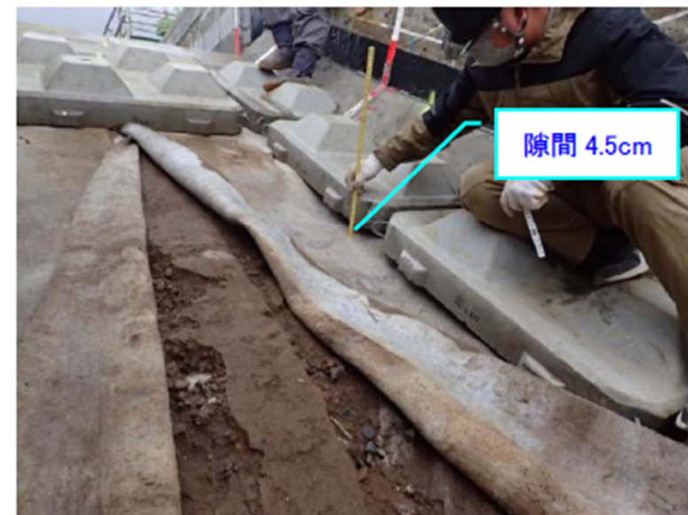
ブロック下の隙間計測状況
