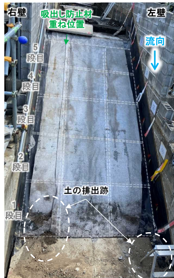
法面ブロック撤去後の状況
