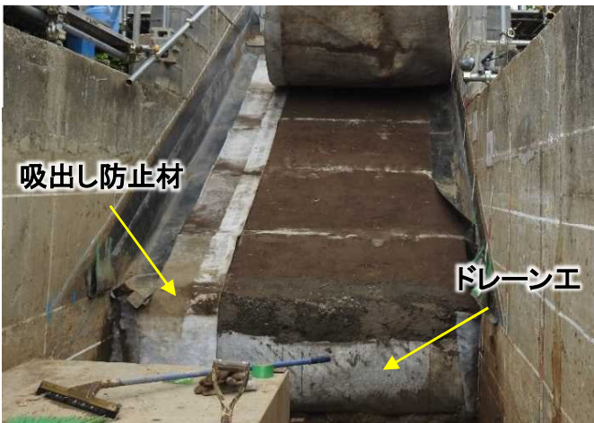
図 吸出し防止材による巻き込み状況
