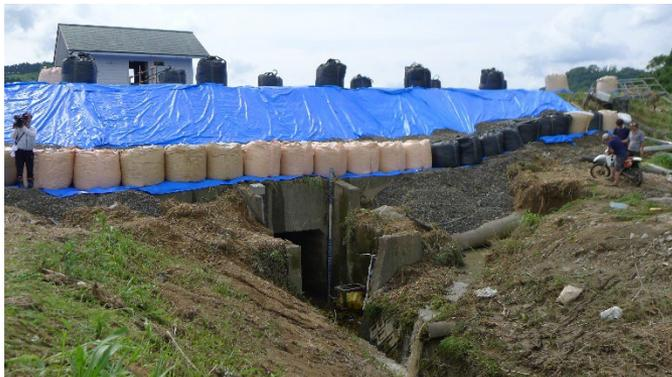
国土交通省によって大型土嚢による決壊部の修復
