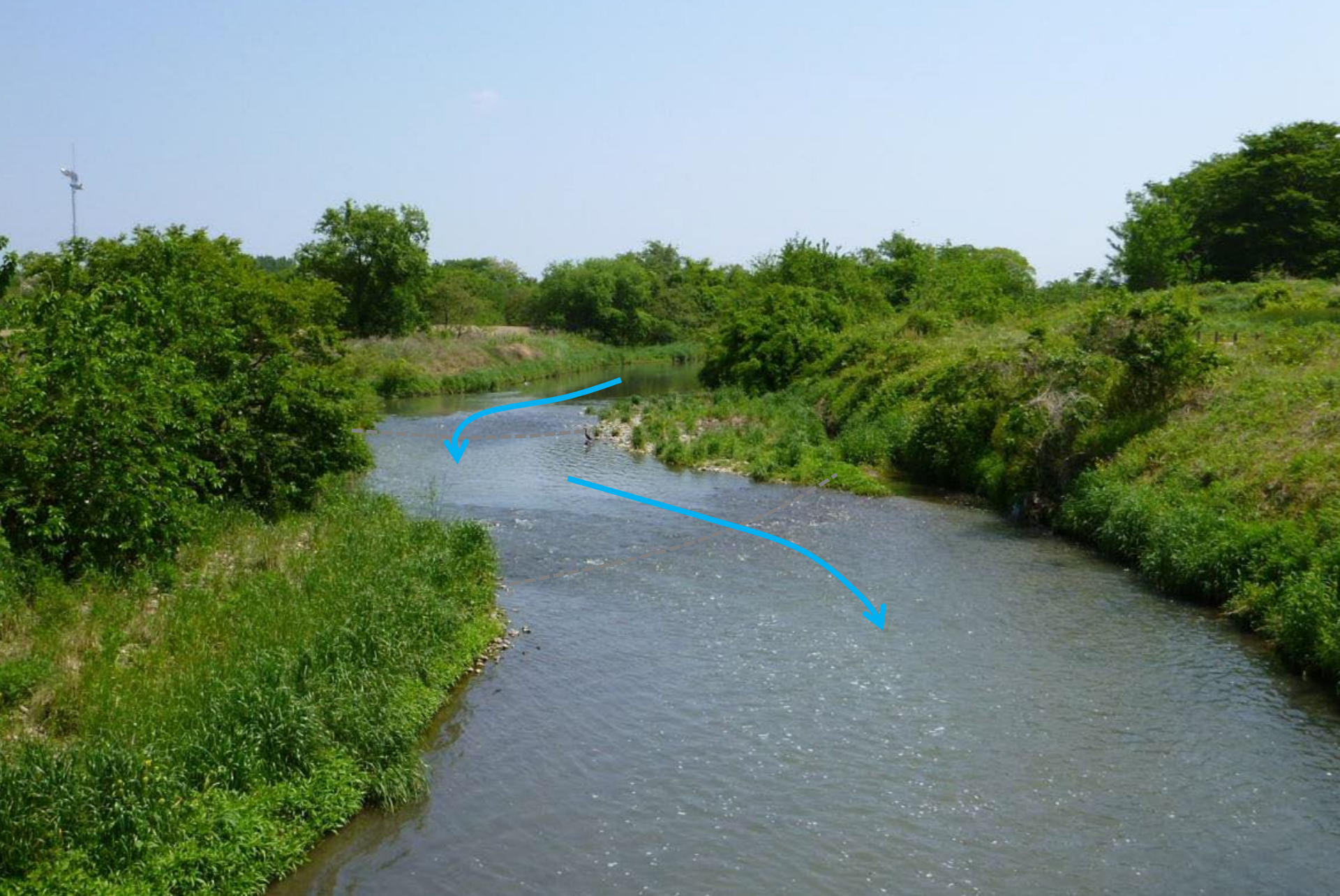
川幅の部分拡幅 新境川 (岐阜県)
