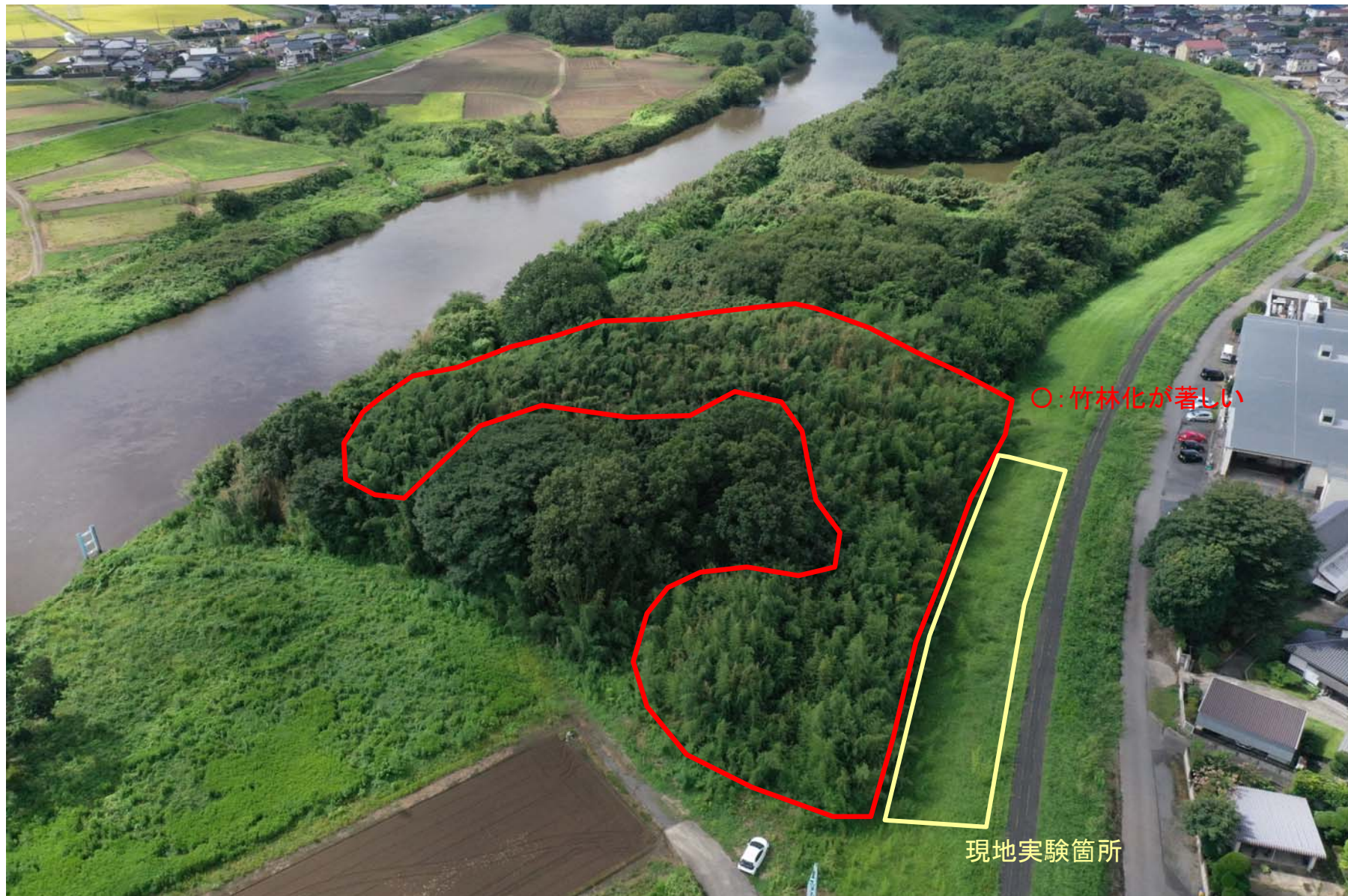
写真-3: 堤防に竹が侵入している区間における河道(高水敷)の竹林化の状況
