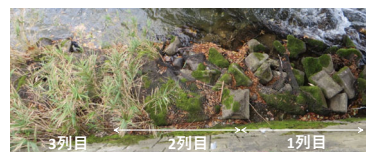
上流端の状況
