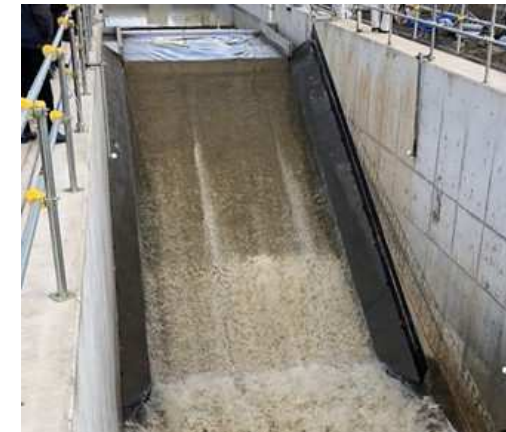
越流水深30cmでの通水状況
