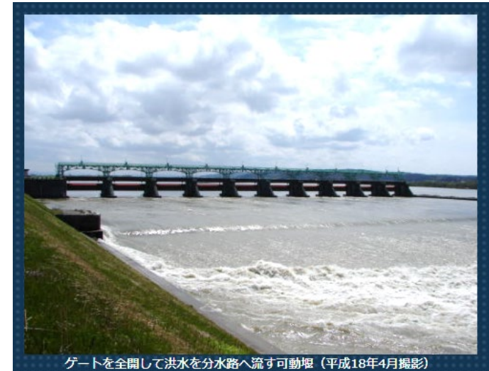
ゲートを全開して洪水を分水路へ流す可動堰（平成18年4月撮影）
