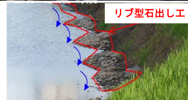
リブ型石出し工
