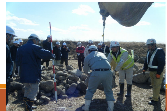
勉強会（工事着手時）
