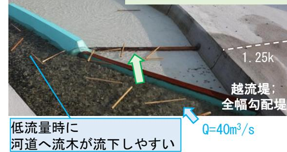
図12 低流量流下時 (Q=40m³/s) の越流堤の勾配堤化による流木流入状況
