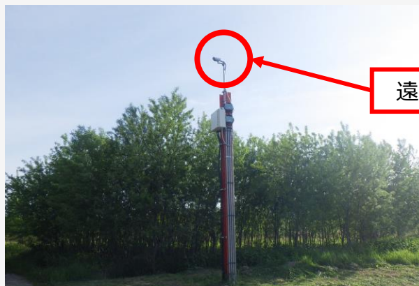
低水路撮影用 水位標第2柱の上部
