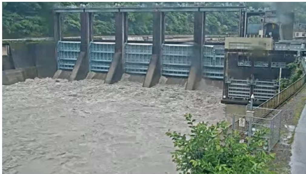
2023年6月 瀬戸石ダム 水位低下中 (電源開発WEBサイトから)
