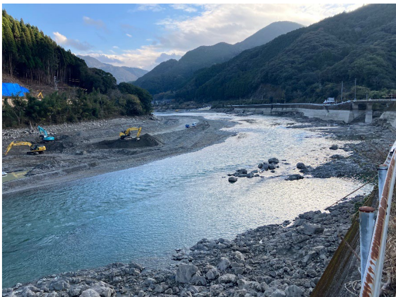
瀬戸石ダム堆砂掘削排除状況(冬期水位低下)
