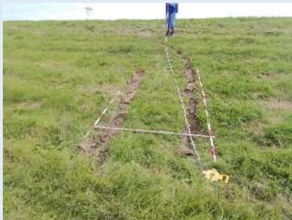
例① 継続変状【人の活動で発生した変状】
