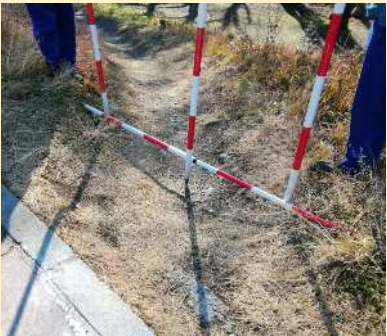
③雨水の集中による侵食 →雨水の流れにより発生
