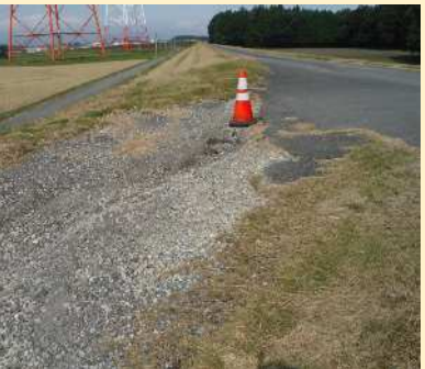
③雨水の集中による侵食 →雨水の流れにより発生
